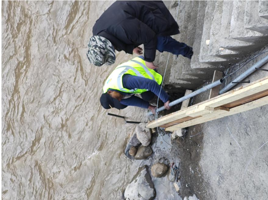
注意事项②：对于距离河岸很远的站点（如下图②、③），气管过长，在途中用钢管铺设或者用水泥掩埋，但是在铺设和掩埋的过程中切勿伤害气管防止划伤或者割破导致气管漏气（在途中安置检查孔，方便以后检修气管而用）。
